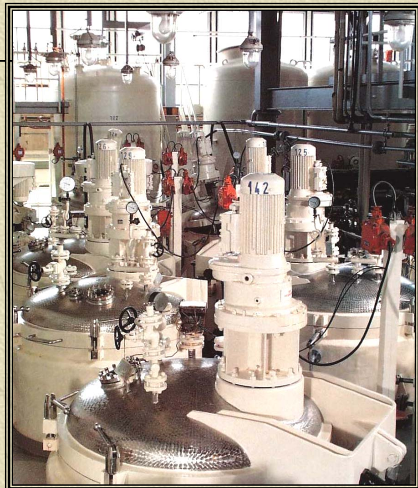
Výrobní hala - izolace
